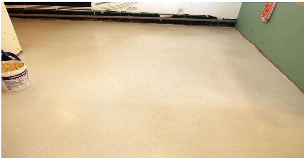
Самовыравнивающие растворы позволяют при соблюдении технологии выводить основание пола практически в ноль, другими словами после заливки такого раствора, полы уже не нуждаются в дополнительной обработке, чтобы соответствовать современным требованиям к укладке напольных покрытий.
