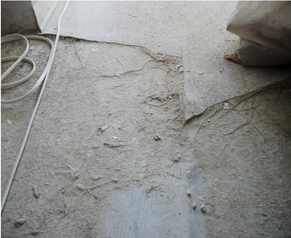
На фото: провода крепятся так, чтобы они не сплывали при заливке пола.
