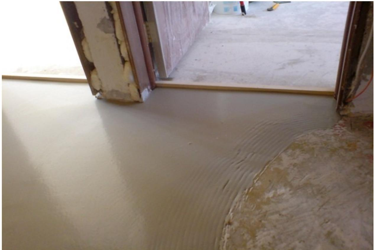
При заливке больших площадей, площадь заливки делится на участки размером до 30 кв.м. каждый, выделенные участки пола заливаются последовательно.
