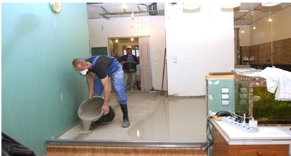
Самовыравнивающиеся наливные полы применяются для финишного выравнивания стяжки пола. Их применение обусловлено современными требованиями к укладке напольных покрытий, которые в настоящее время имеют большую популярность. К этим напольным покрытиям относятся сборные полы, такие как ламинат и паркетная доска. Для того чтобы качественно уложить напольное покрытие к основанию пола предъявляются следующие требования - сухой, плоский, в горизонтальном уровне.
