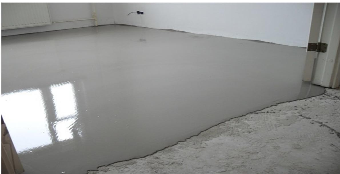
раствором наливного пола (толщина от 5 до 20 мм).
